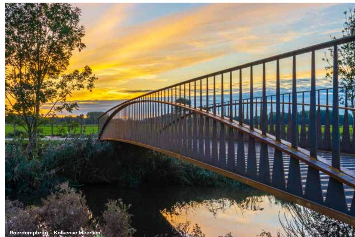
Roerdompbrug - Kalkense Meersen
