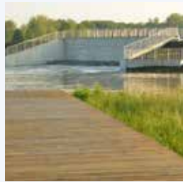
In- en uitwateringssluis
