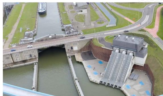
*Hydraulische Pumpen sparen Wasser und erzeugen grüne Energie.*
