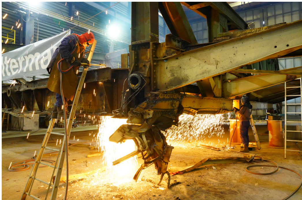
■ Er valt niet naast te kijken: waar het brugdeel is aangevaren, is het staal compleet verwrongen en verdraaid. Alle vervangstukken moeten op maat worden gemaakt.
