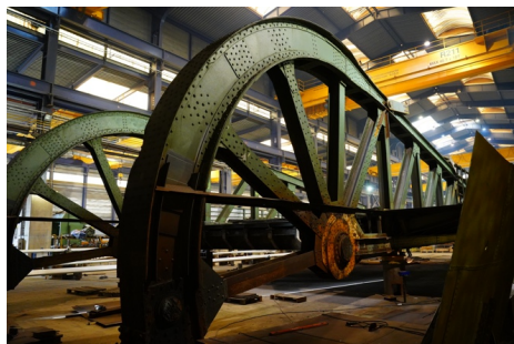
■ Er valt niet naast te kijken: waar het brugdeel is aangevaren, is het staal compleet verwrongen en verdraaid. Alle vervangstukken moeten op maat worden gemaakt.
