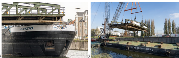
■ Na de aanvaring door een olietanker werd het beschadigde brugdeel naar Aelterman in de Gentse haven vervoerd.
